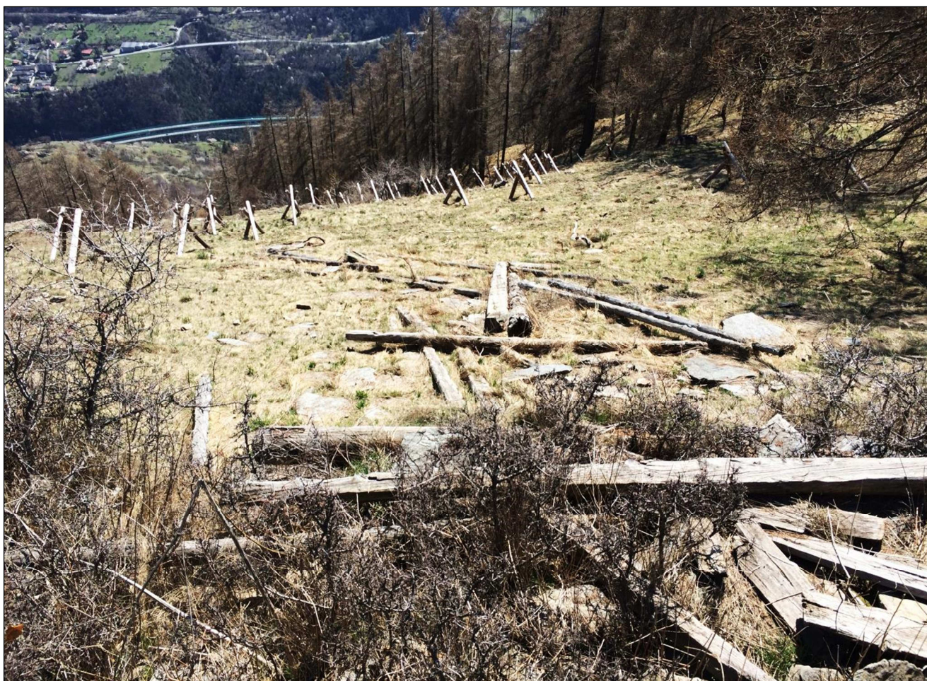
Fig. 5.4 - Elementi del tetto trasportati a valle dalla valanga proveniente a monte della zona individuata dallo studio di fattibilità per la posa delle linee paravalanghe
