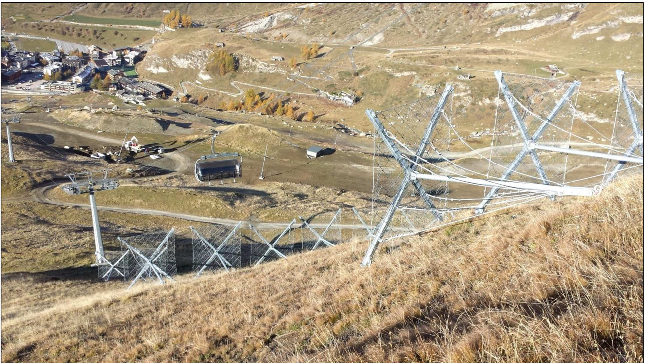
Fig. 6.6 – Esempio elementi fermaneve
